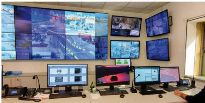
*Tecnologie di nuova generazione per la sala operativa di PSA Genova Pra'. L'intera componente di video sorveglianza è gestita dalla piattaforma software AiVu di Aitek: il sistema di video management AiVu-VMS, i client per la gestione dei decoder e del videowall, i monitor per la visualizzazione degli allarmi generati dagli algoritmi di intelligenza artificiale.*
