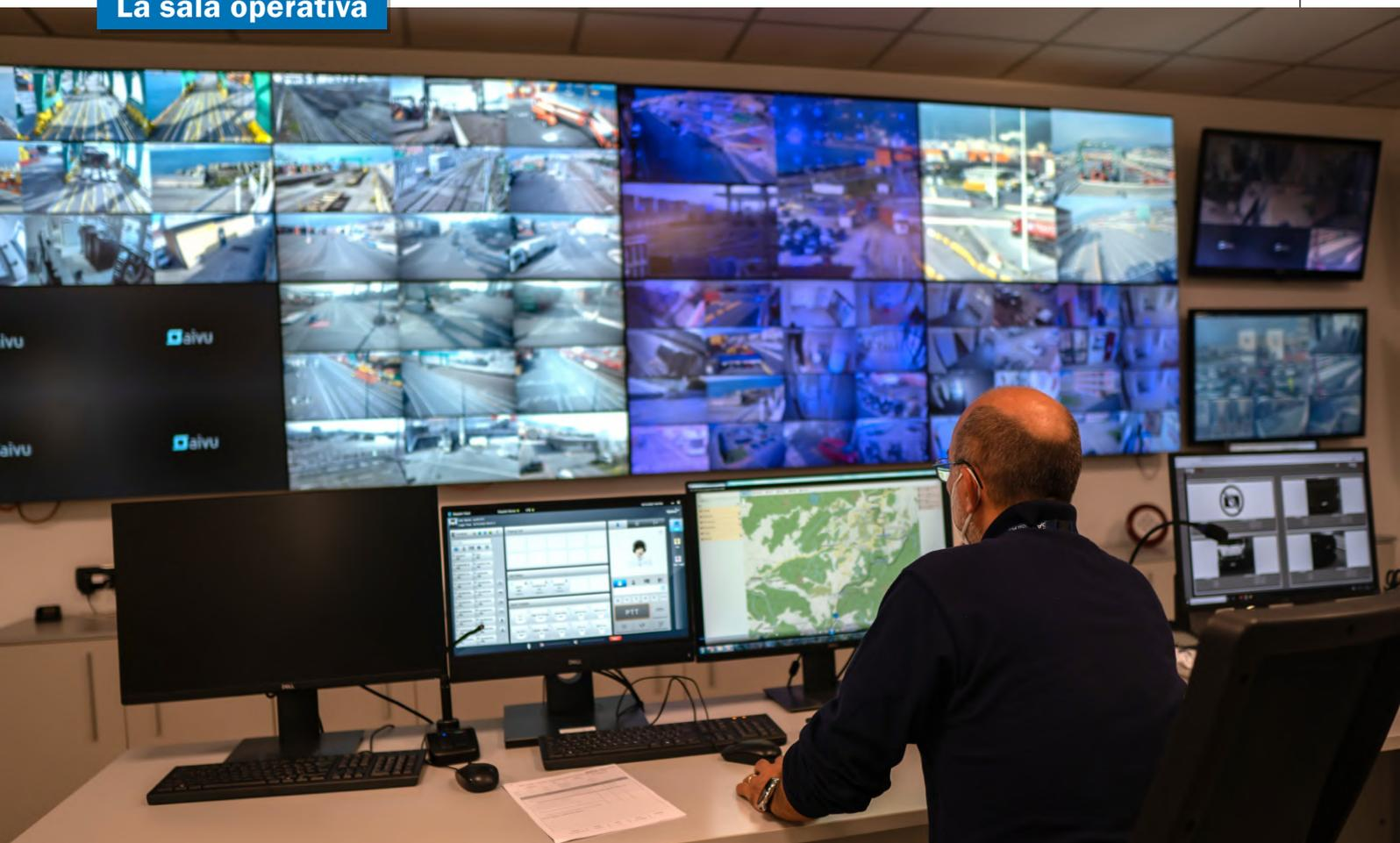
**Tecnologie di nuova generazione per la sala operativa di PSA Genova Pra'. L'intera componente di video sorveglianza è gestita dalla piattaforma software AiVu di Aitek: il sistema di video management AiVu-VMS, i client per la gestione dei decoder e del videowall, i monitor per la visualizzazione degli allarmi generati dagli algoritmi di intelligenza artificiale.**
